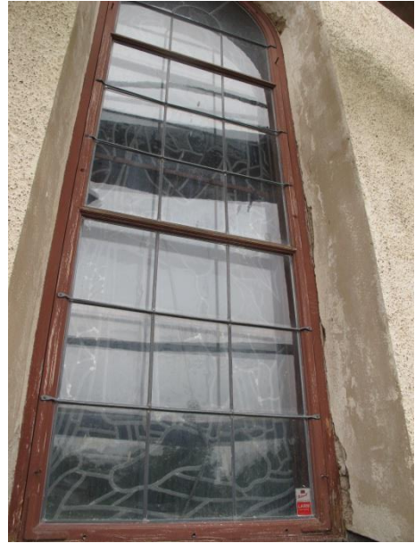
Ett av fönstren före åtgärder.
