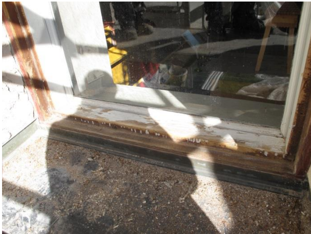
Utrymmet mellan ytter- och innerbåge har slipats för att sedan målas.
