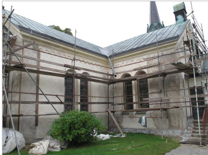
Lagning av putsen pågår.
