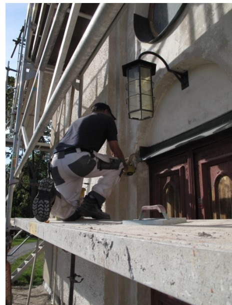
Lampa ovanför södra entrén. Putslagning pågår.
