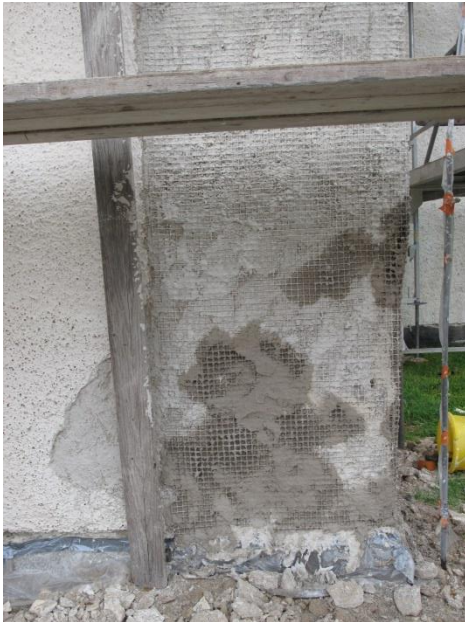
Ett av hörnen har nätats för att få putsen att fästa ordentligt.
