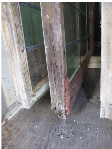
Fönstren inför åtgärder. Bilden till vänster visar ett rötskadat bottenstycke. Bilden ovan visar insidan av en ytterbåge.
