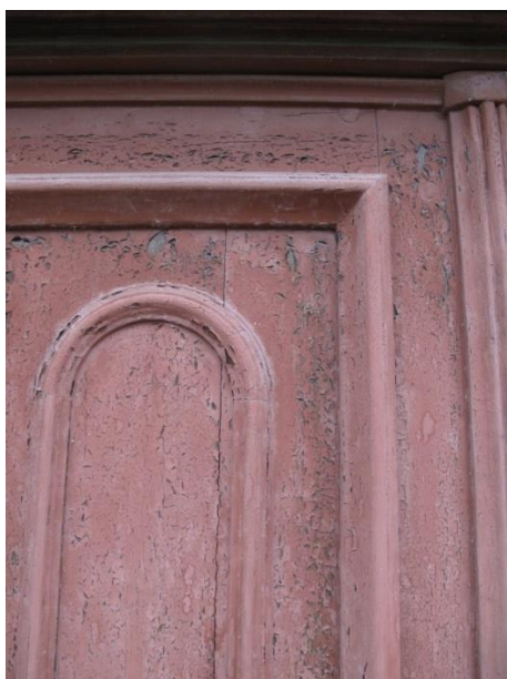
Porten i väster före åtgärder.
