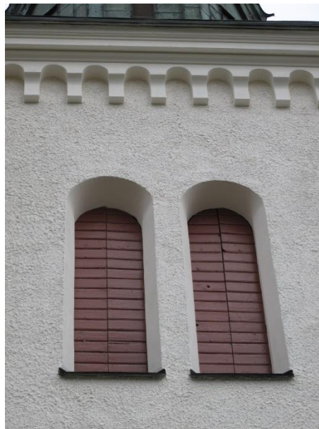
Solbänkar av järn borstades rena och målades med Ottossons linoljefärg i en svart kulör, NCS S 9000-N.
