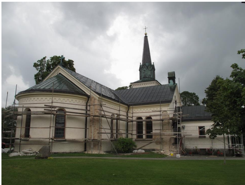
Näsby kyrka. Arbetena har precis påbörjats och lös puts knackas ned.
