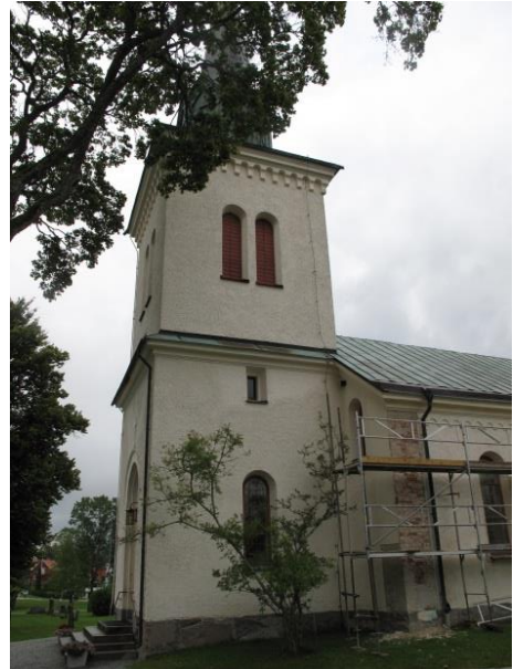
Tornet med tornluckor före åtgärder.
