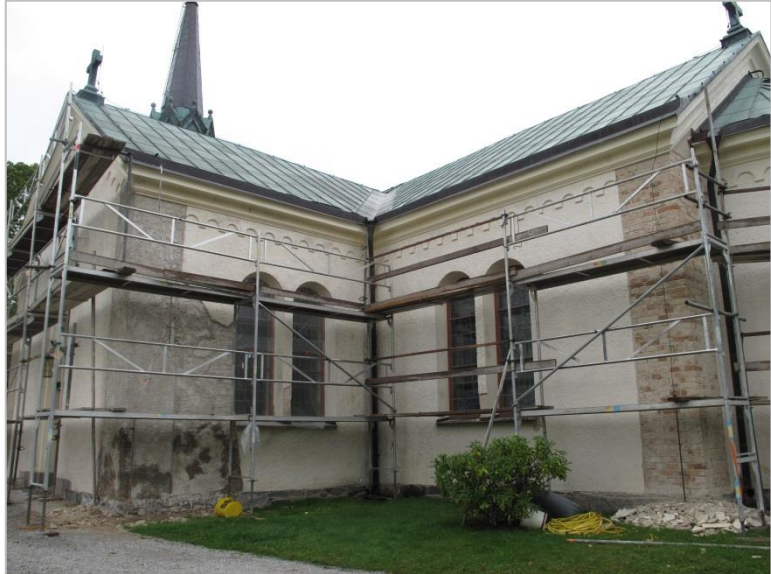
De rundbågeformade fönstren är placerade om två och två. Sydöstra hörnet.
