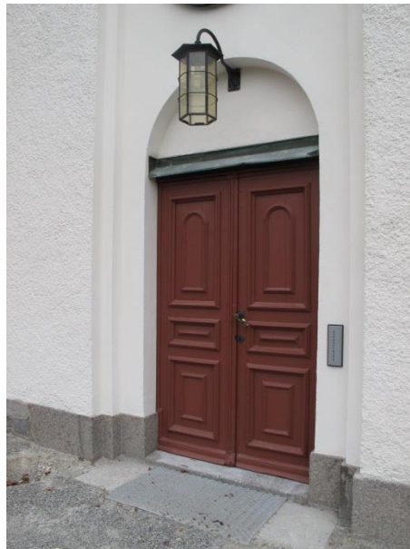
Södra porten efter åtgärder.
