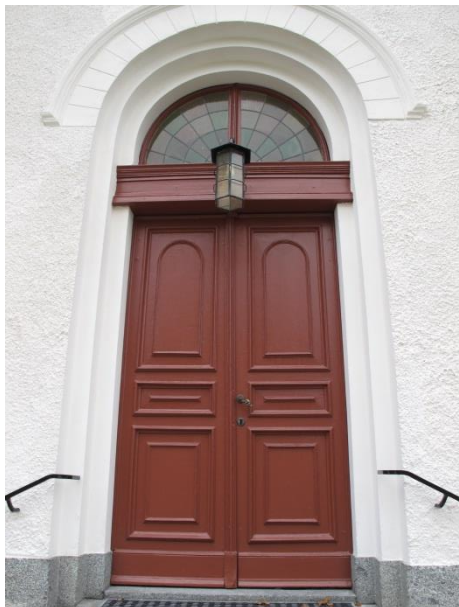
Västra porten efter åtgärder.
