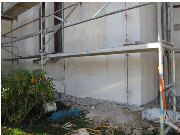
De åtgärdade partierna på fasaden samt knuten har grundmålats med en CD färg för att sedan slutligen målas med kalkfärg.
