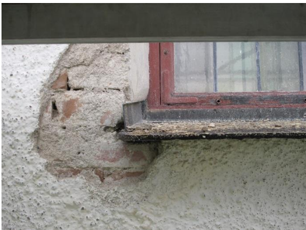
I bågens bottenstycke syns de små hål som tidigare tagits upp för att öka luftgenomströmningen mellan ytter- och innerbåge.
