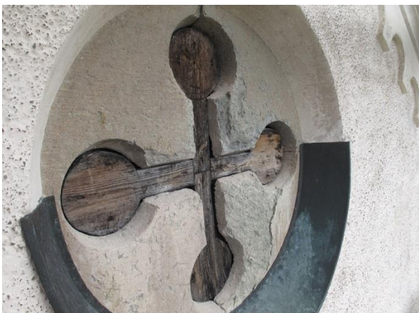
En av öppningarna i södra korsarmens gavelröste. Dekorativt huggen kalksten ger korsformen. Kalkstenen har börjat att vittra sönder. I detta projekt fanns inte tid och pengar för att åtgärder.
