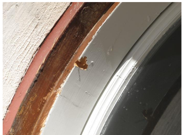
Längst upp i varje båge finns två borrade hål. De ansågs dock vara för små för att fungera.
